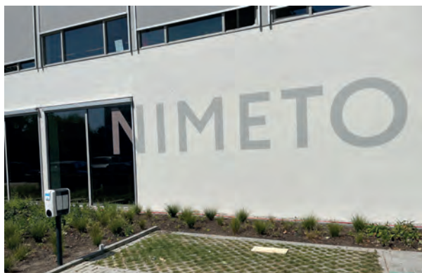
▲ Gevelsigning geschilderd met behulp van sjablonen, op raam contoursneden.
